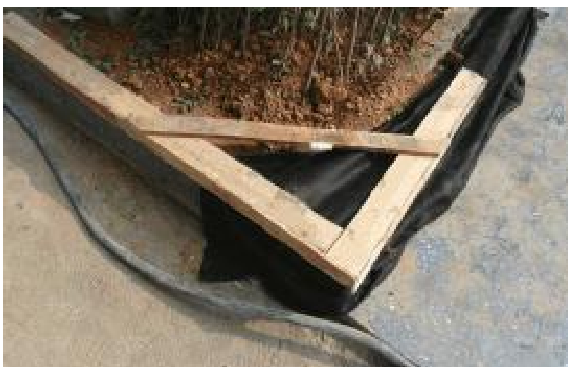
参考案例：树池压顶的护角保护
