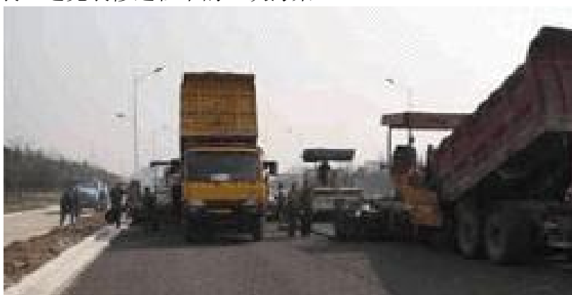
参考案例：沥青浇筑过程中的侧平石保护
