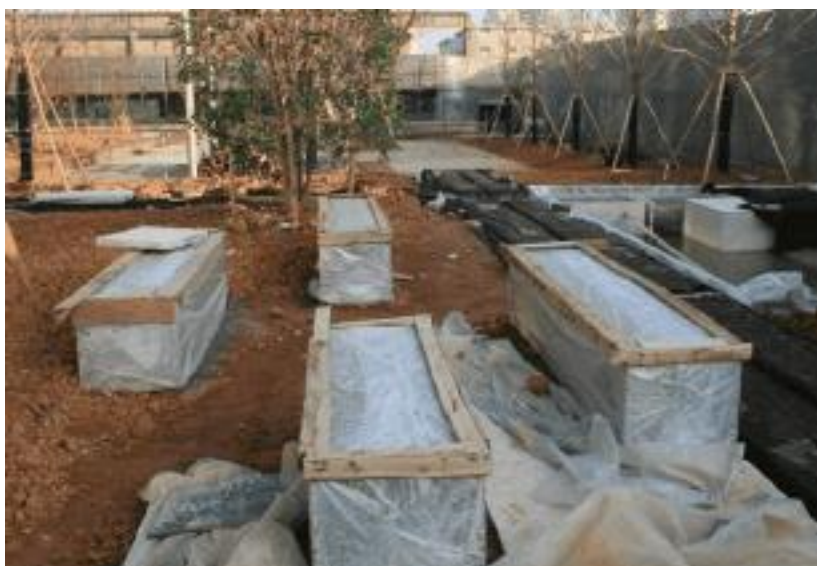
参考案例：挡墙及座凳的护角保护
