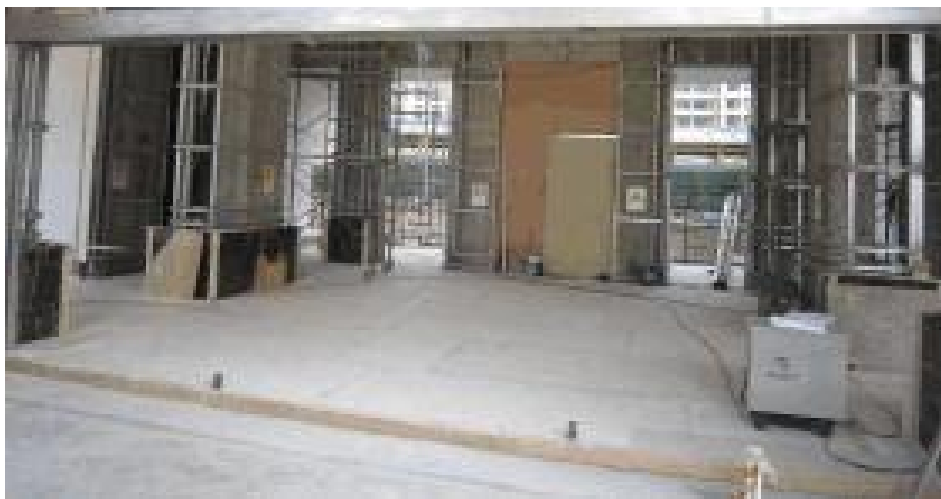
参考案例：架空层装修过程中的地面成品保护
