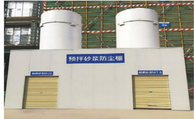
干粉砂浆采用砂浆罐储存
