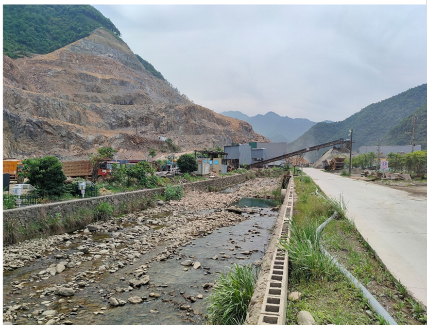
图 4.5-10 防洪控制断面现场照片
