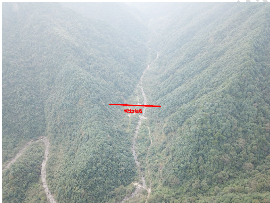
图 3.4-1 上坝址地形地貌
